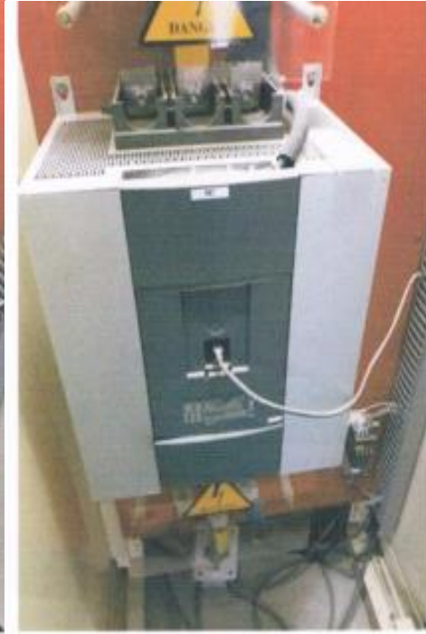
Softstarter มอเตอร์ M2 340 HP. ผลิตภัณฑ์ ABB.รุ่น PSTX570-600-70
