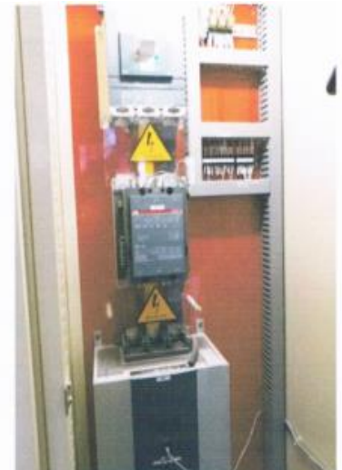
Softstarter มอเตอร์ M1 340 HP. ผลิตภัณฑ์ ABB รุ่น PSTX570-600-70
