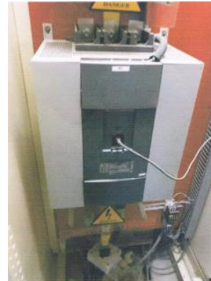
Softstarter มอเตอร์ M1 340 HP. ผลิตภัณฑ์ ABB รุ่น PSTX570-600-70
